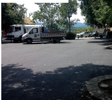
Travaux d'embellissement sur la Place Neuve.
