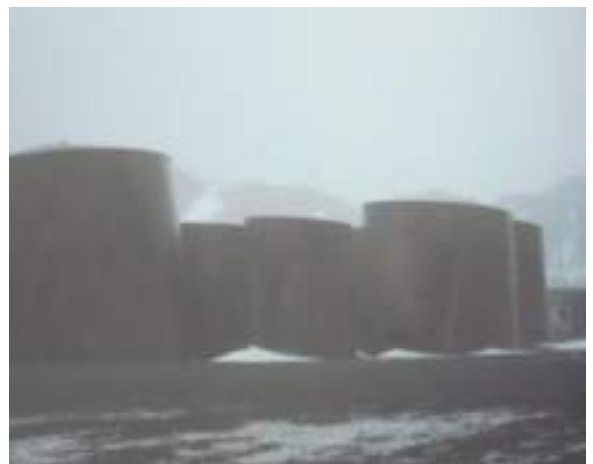
Tristes vestiges d'une usine à huile de baleine désaffectée
