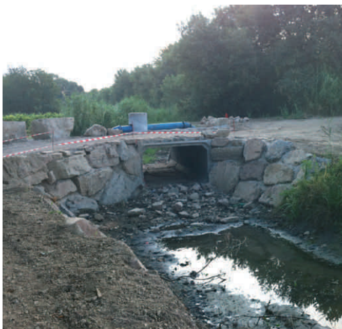
Les travaux d'aménagement des ruisseaux : ici le Saint-Pierre
