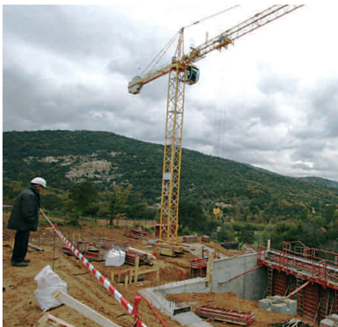
Chantier des logements du Vallon des fées et de La Garde
