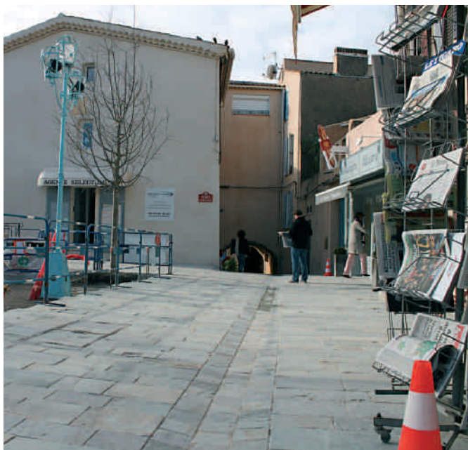
Les travaux de réhabilitation de la place Vieille
